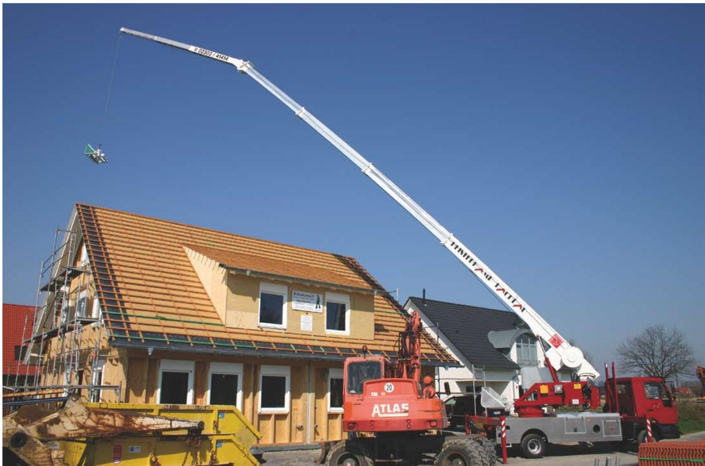
Bei Dachdeckern beliebt: der Autokran mit einer Tragkraft bis 2.000 Kilogramm
